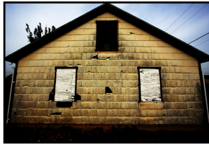
Enkeltbilde farge papir - Antatt - Gammelt gult hus med tre vinduer - Terje Angeltveit
